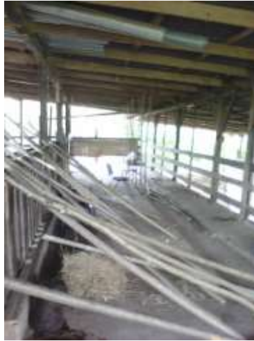
Foto 7.- Acondicionamiento de las instalaciones
