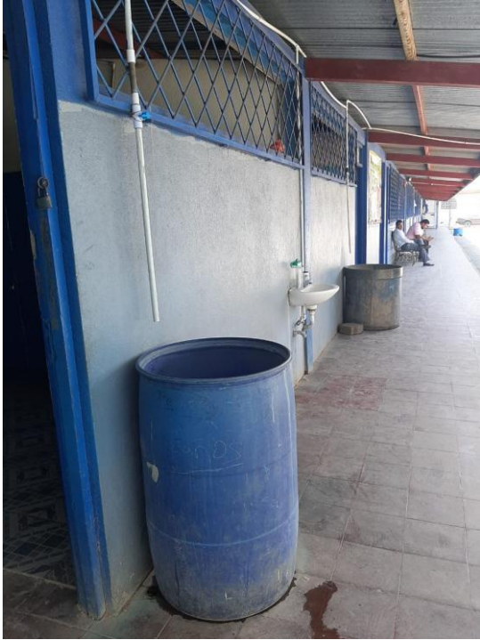
Figura 15: Barriles con agua para lavar los baños y lava manos.
