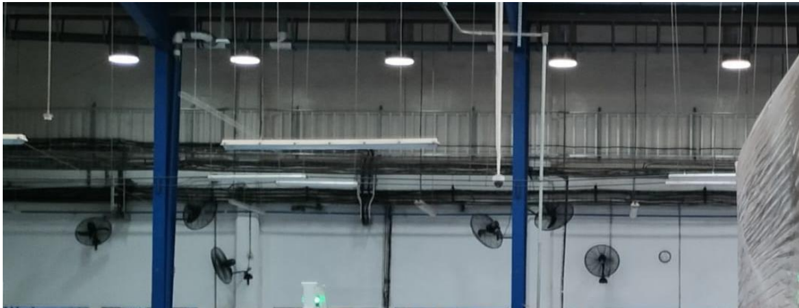
Ilustración 5 Ventilación en el área de embalaje
