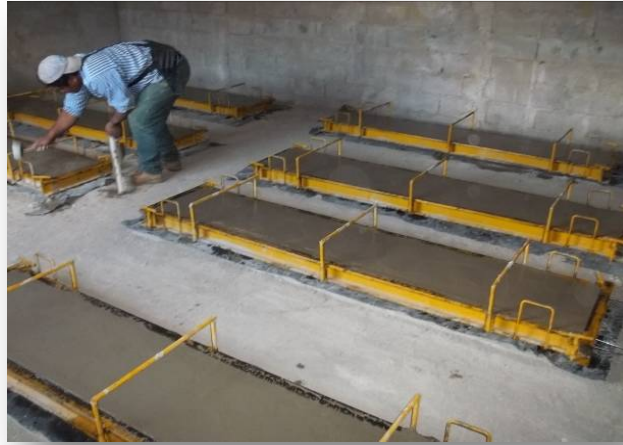
Imagen No. 3 Moldes para Elaboración de Losas
