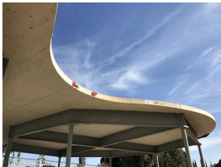
IMAGEN 25 ESTRUCTURA DE TECHO
