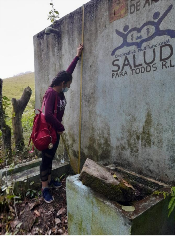
Figura 20. Toma de medidas a pila de almacenamiento
