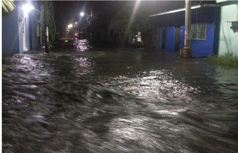
Figura 12. Calle inundada del barrio Estelí, 10 min después de la lluvia. Fuente. Propia
