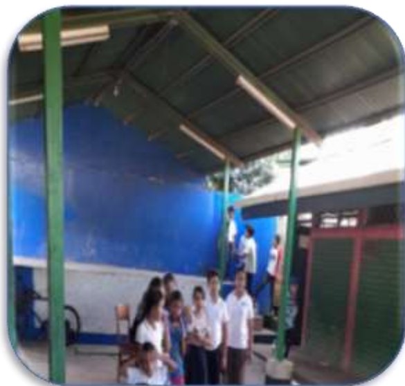
Ilustración 4 Auditorio y sanitarios del centro Escolar
