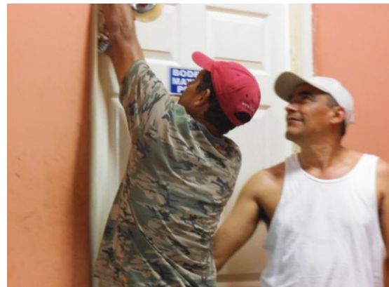
Fig. 13. Sellado de la instalación.
