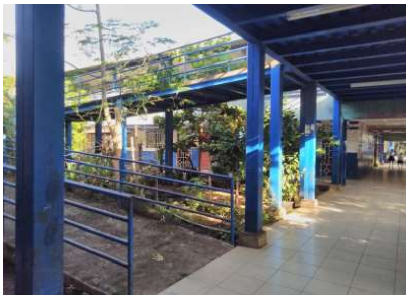
Nota: Rampa que conecta el primer pabellon y segundo pabellon.
