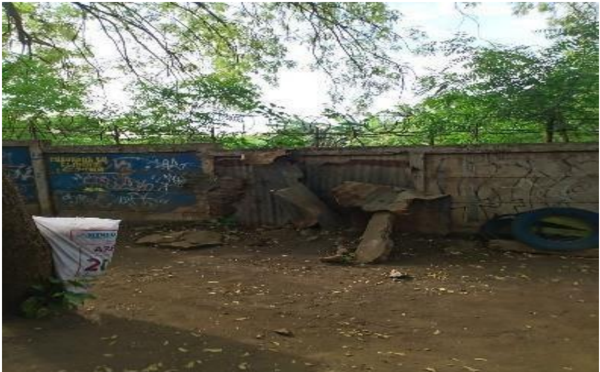
Ilustración 7 Muro Perimetral lateral
