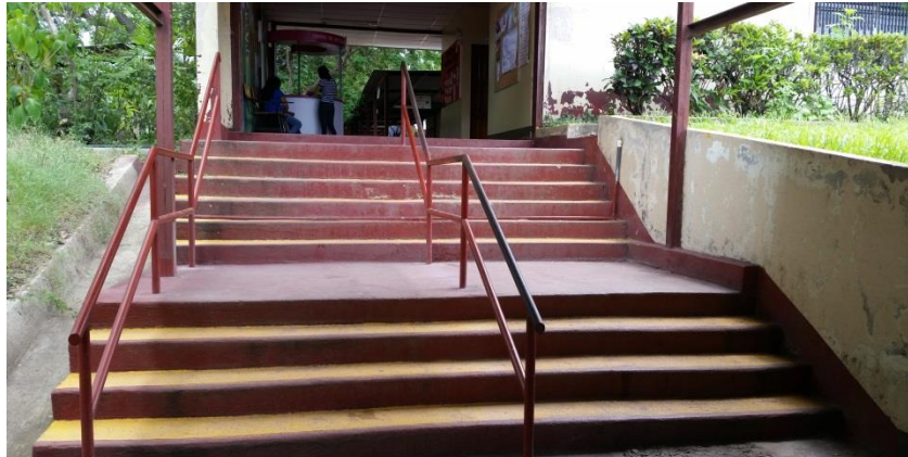
Ilustración 3, PASA MANOS EN ESCALERAS EN FAREM.
