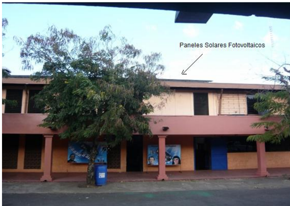
Fig.9 Vista de la ubicación de los Paneles Solares Fotovoltaicos sobre el techo del edificio.
