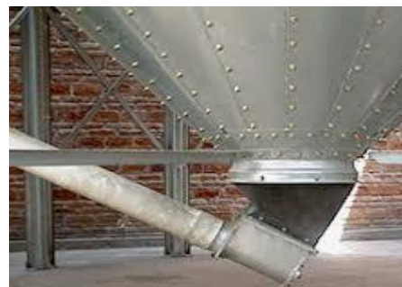
Ilustración 16: Tolva empotrada en el piso
