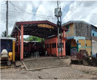
1. Estación de Bomberos
