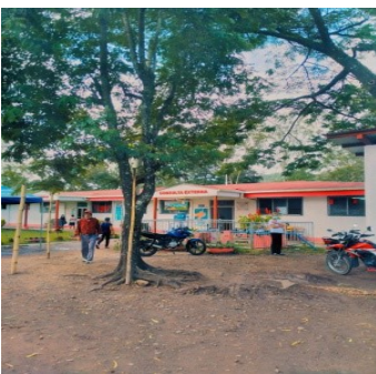
Imagen N° 03 Centro de salud Denis Gutiérrez. Fuente propia
