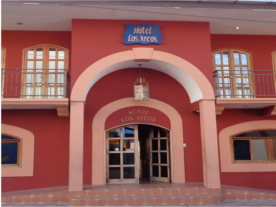
Ilustración 3: Hotel los Arcos ubicado en la Ciudad de Estelí-Nicaragua
