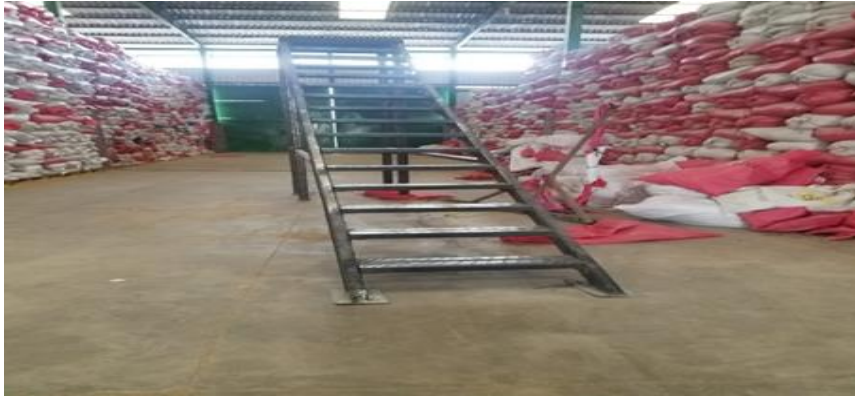
Figura 5: Rampa metálica sin protección en costados, ubicada en área de almacenamiento de granza seca
