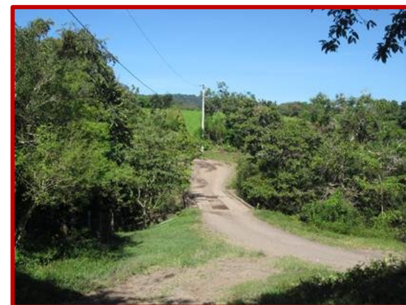
Figura N° 28. Puente de La Estanzuela. Fuente: (Propia).
