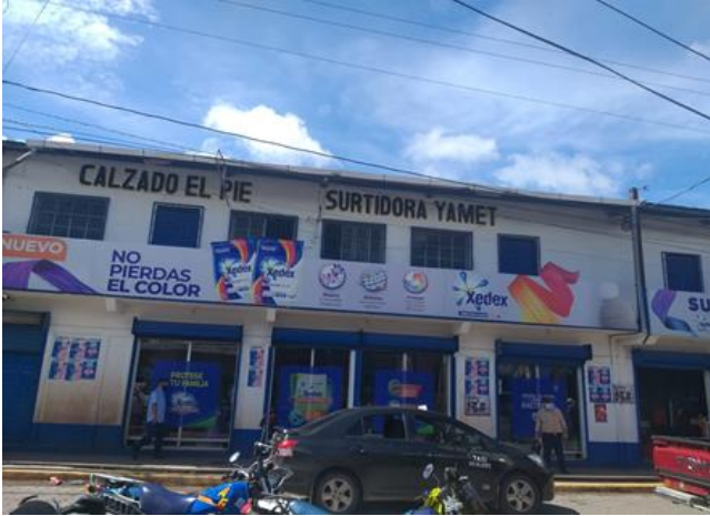
Ilustración 5 Vista frontal del edificio de la surtidora
