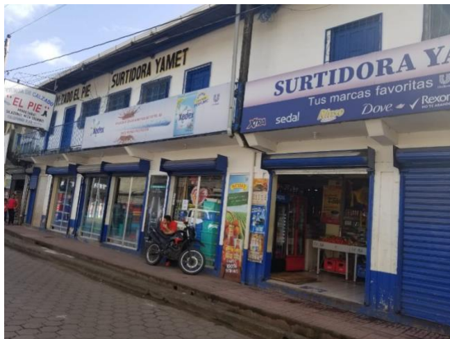
Ilustración 3 Vista lateral de la surtidora
