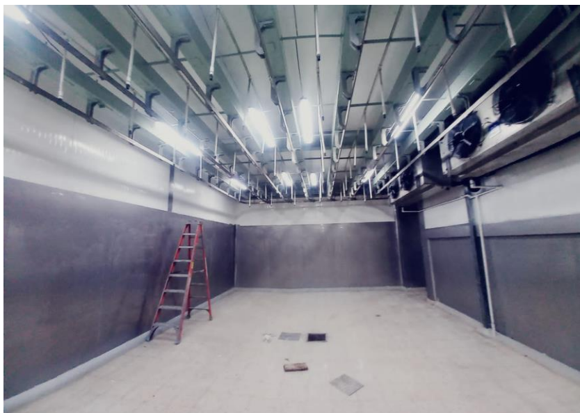
Figura 3. Área de cuarto frío
