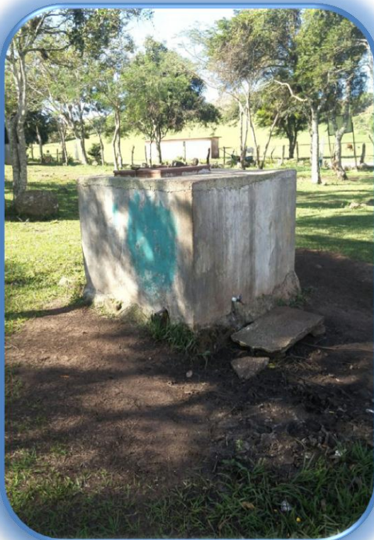
Figura 9. Construcción de pila para abastecimiento de agua.
