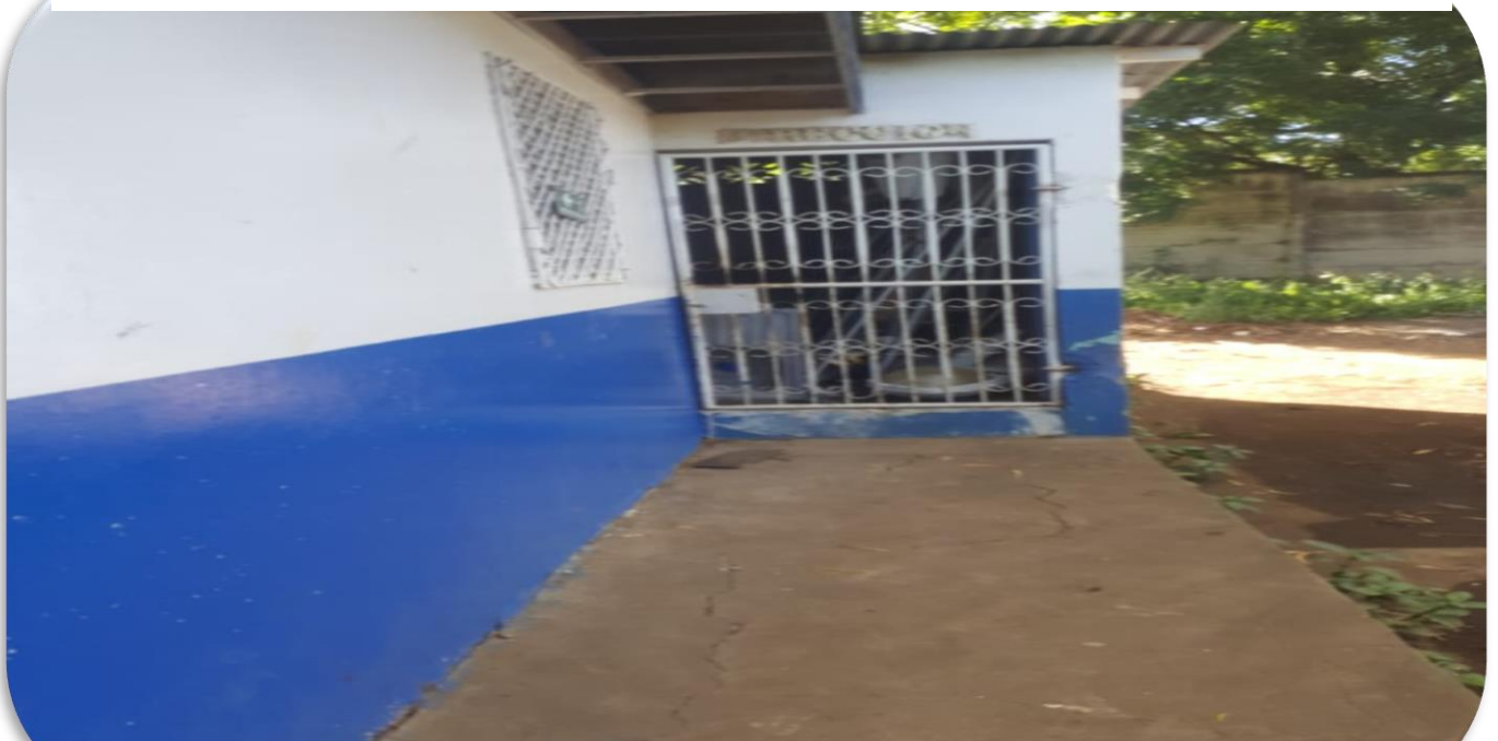
Bodega de materiales No. 1
