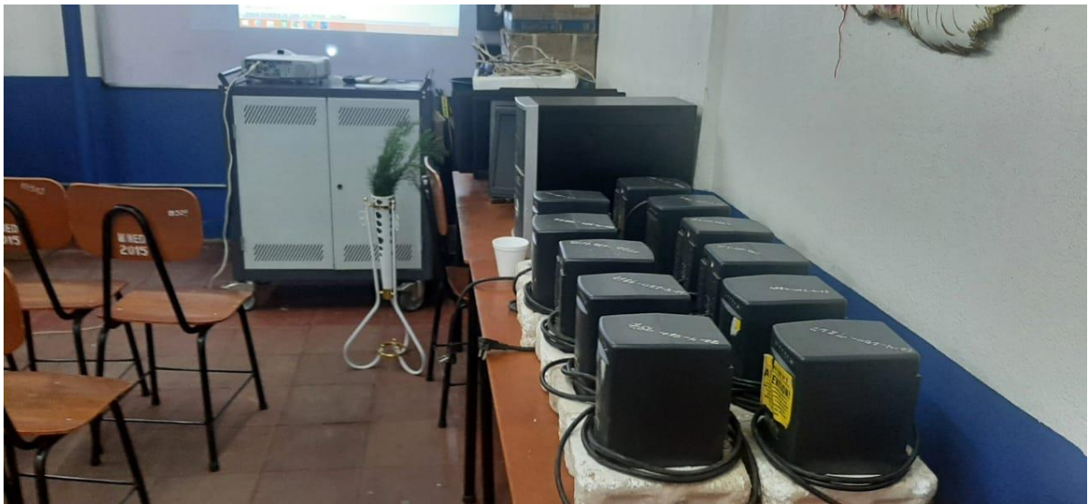
Equipos del Aula TIC.
