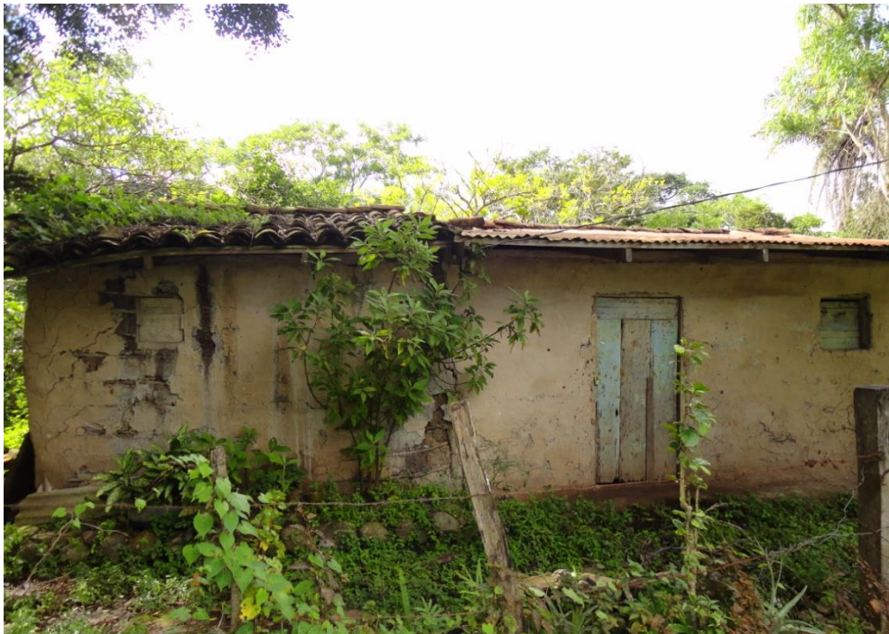
Figura No. 17 Casa de Taquezal
