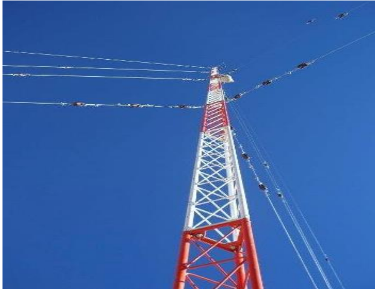
Imagen 18 Torre arriostrada (MEGACOM, 2021)
