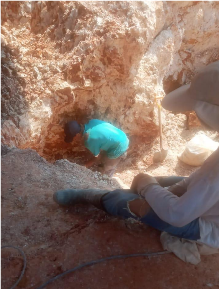
Imagen 12.1.12.1.1 Extracción del material con rota martillo.
