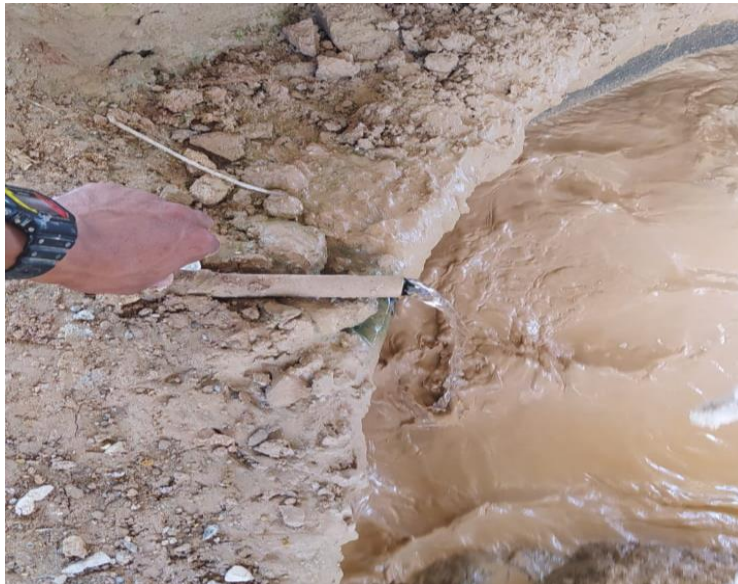
Imagen 12.1.9 Abriendo la llave para el paso de agua.
