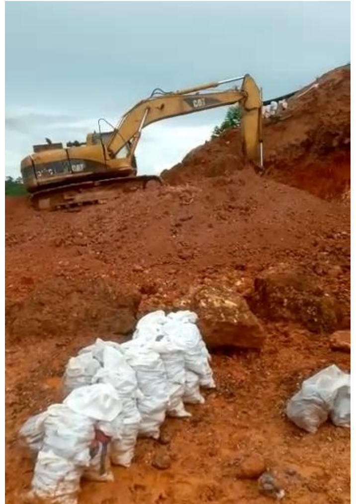
Imagen 12.1.2 Extracción del material con retro cavadora.
