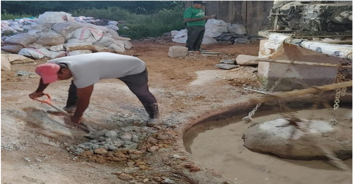
Imagen 12.1.6 Agregado del material a la rastra Mezcladora.
