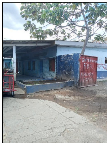
Figura 16. Antigua estación policial, llamada El Comando
