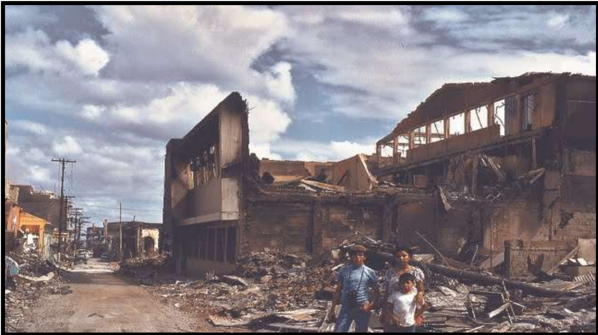
Figura 9. Ruinas del edificio Foto Lux. Barrio San Antonio, calle 15 de septiembre, Managua 1972.
