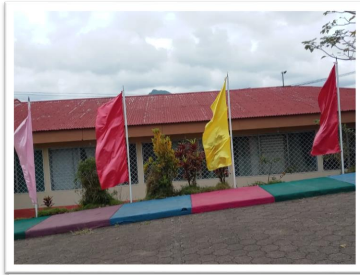
Ilustración 16 Foto panorámica del hospital
