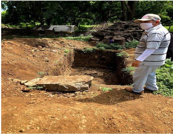
Ilustración 5: Preparación de Reservorio 1.5 Ancho; 4 metros Largo y 1.20 de profundidad
