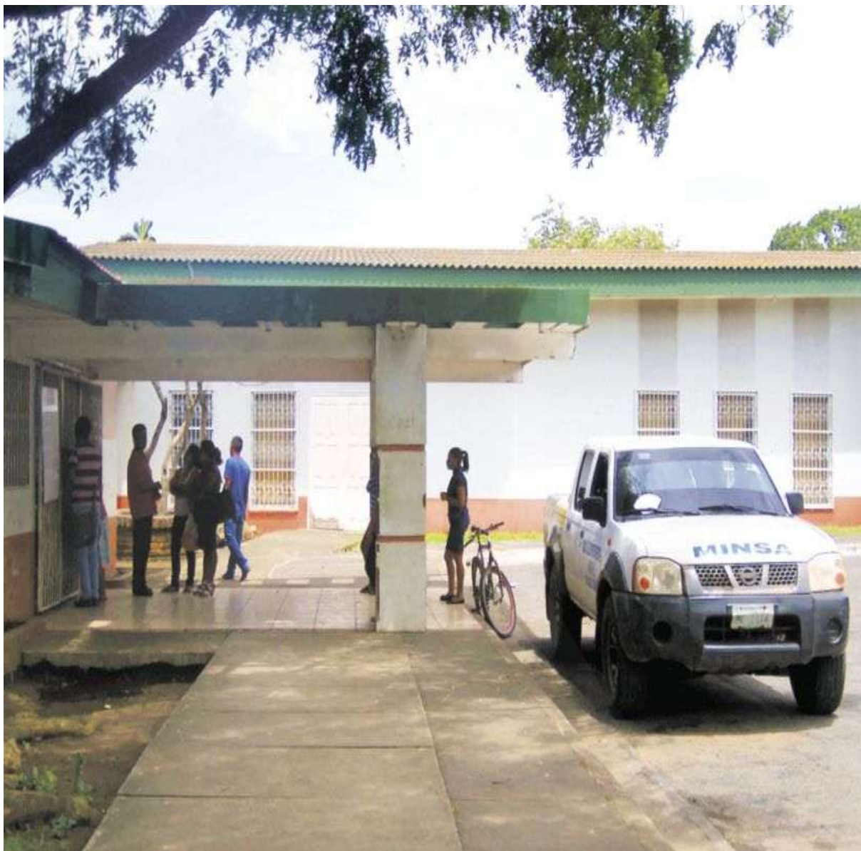
Fig. 2 Instalaciones del Hospital Escuela Regional Santiago de Jinotepe
