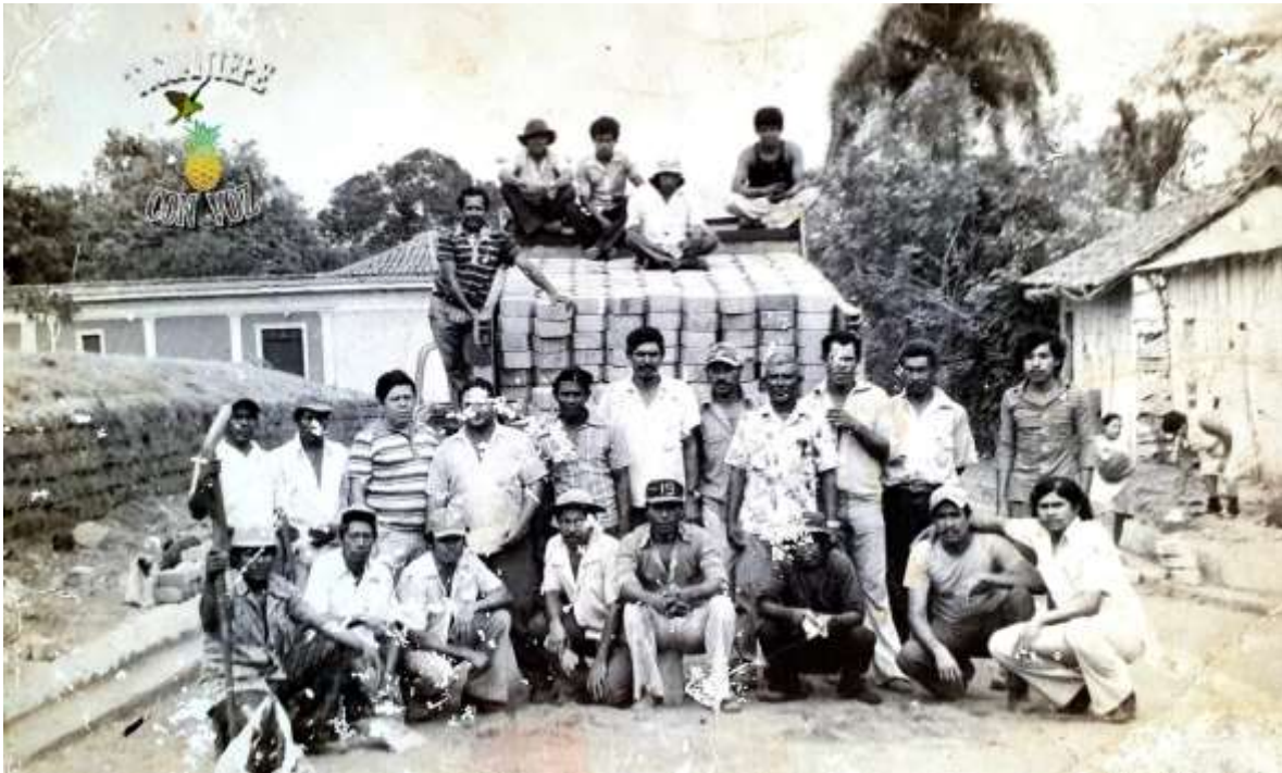
Foto tomada el día que se inició la pavimentación de la calle real, nótese al lado izquierdo el modelo arquitectónico diferente a la casa de la derecha. Urbina, L.
