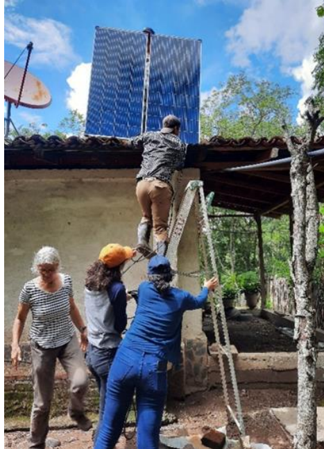
Foto. Montaje de los paneles
