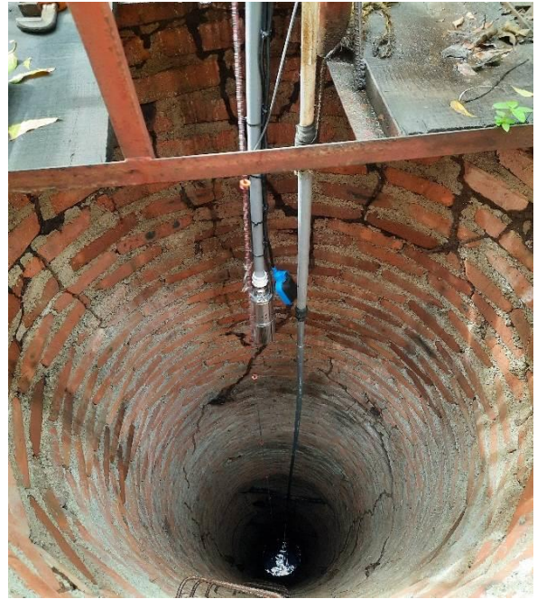
Foto. Instalación de la bomba
