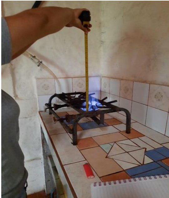
Foto. Altura de la llama en cocina araña
