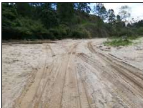
Imagen 7: Compactación del río.
