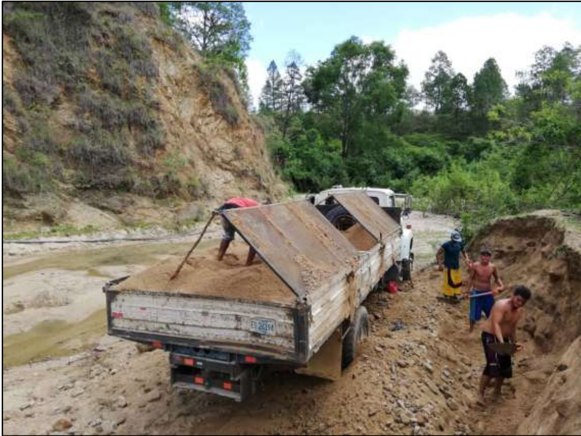
Imagen 8: Utilización de zarandas para colado de arena.
