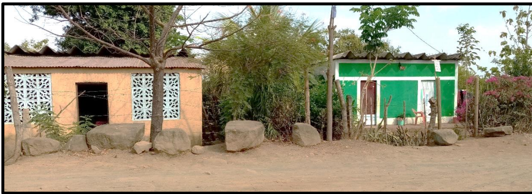
Foto 3. Edificación considerada en estado Buena.
