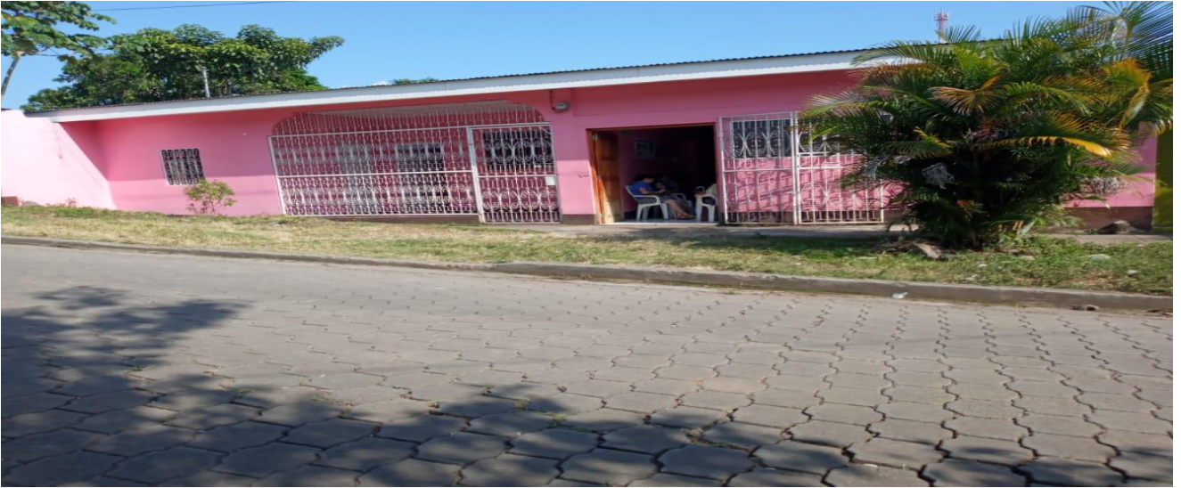
Ilustración 3 FACHADA PUESTO SALUD GREGORIO MONTOYA
