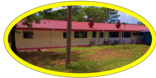
Ilustración 3 VISTA TRASERA DEL CENTRO DE SALUD
