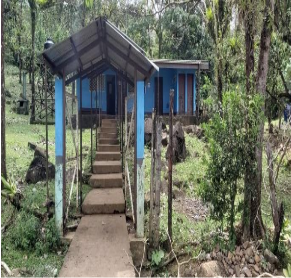
Fachada Puesto Wanawas, Rio Blanco
