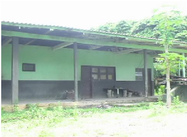
Fotografía 3: Casa de comando de la guardia nacional del General Somoza, ubicada en el interior del Cerro Mokoron. Fuente: Sánchez, J. & Morales D. (2007).
