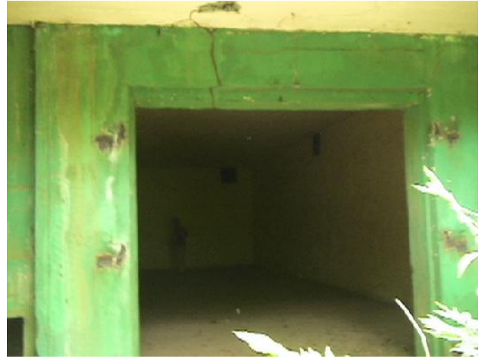
Fotografía 6: (Vista Interna) Depósito subterráneo de armas ubicado bajo el Cerro Mokoron. Fuente: Sánchez, J. & Morales D. (2007).
