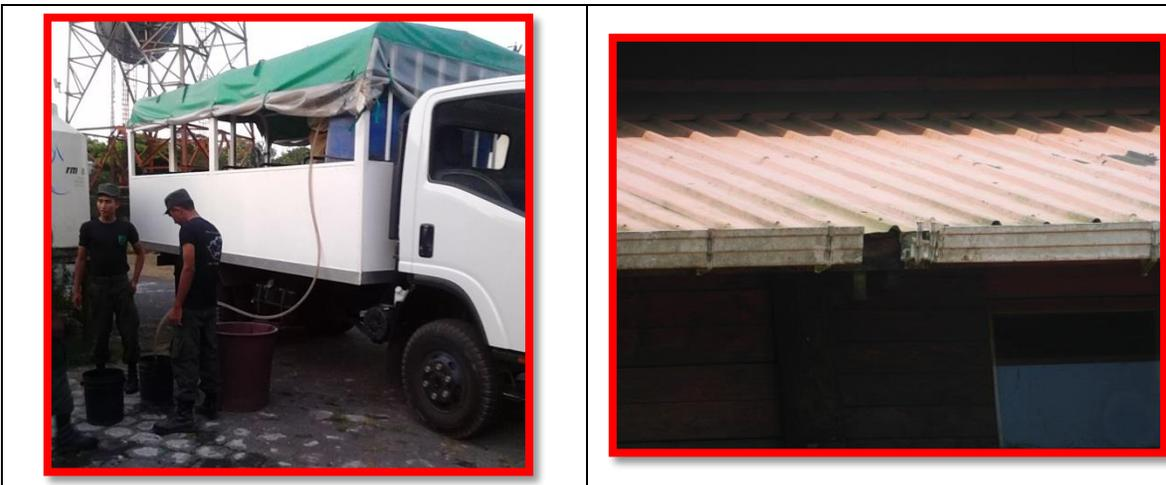
A la izquierda se observa la forma de traslado del agua potable a la estación biológica la cual no se manipula de manera adecuada ni se traslada en un medio de transporte correcto. A la derecha se observa el deterioro de los canales de recolección de aguas pluviales.
