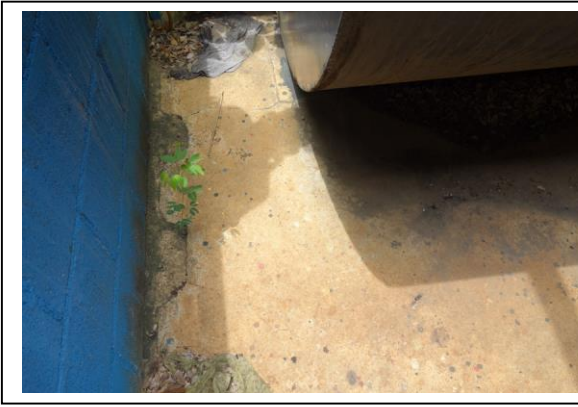
Figura 12: A la izquierda se observa permeabilidad en el piso del área de almacenamiento de bunker. A la derecha techo de asbesto.
