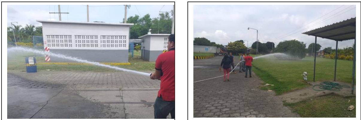
Figura 7: Disponibilidad de equipos de seguridad. Pruebas de las mangueras contra incendio.
