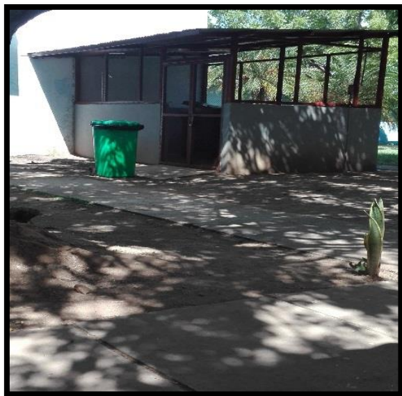
Figura 1. Casetas de Almacenamiento intermedio
