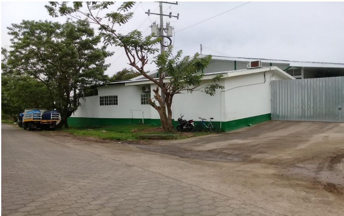
Figura 1 Fachada de la planta Lácteos "Las Tucas"
