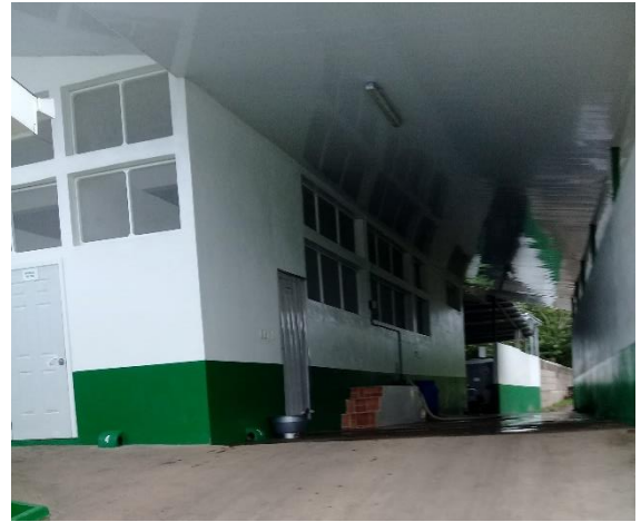
Figura 11 Recepción de leche
