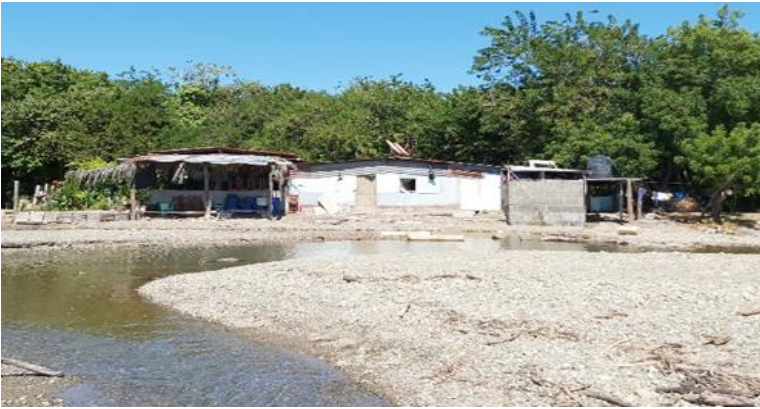
Foto N°.11 Vivienda construida próxima al ecosistema
