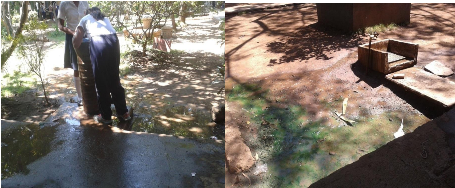
Foto 1. Alumnas tomando agua. Bebedero sin drenaje. Foto 2. Lavandero de lampazo derrame de agua estancada
