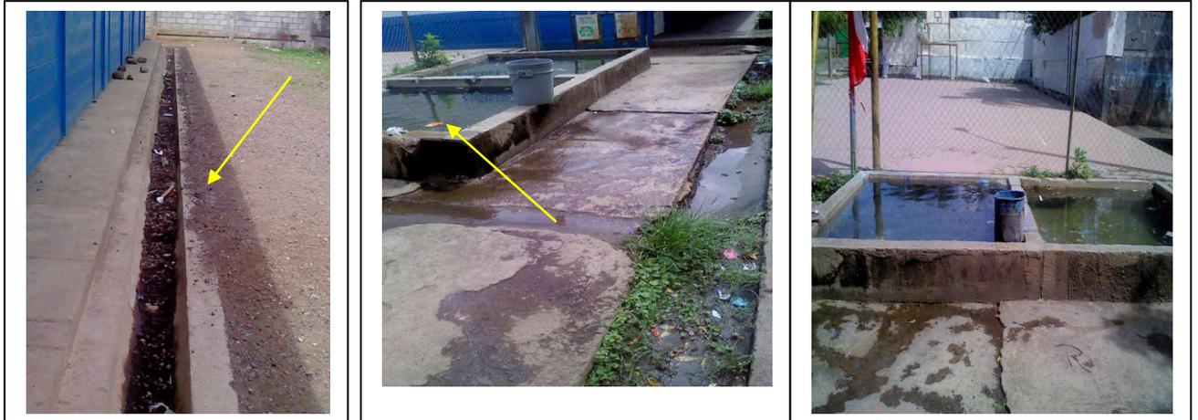
**A la izquierda canaleta llena de material de construcción que impide el paso del agua pluvial. Al centro una pileta que ha creado charcas. A la derecha la misma totalmente descubierta, siendo un principal creadero de vectores.**
