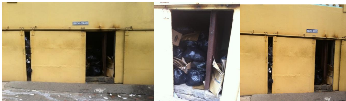
Foto 5, 6 y 7: Bodega de almacenamiento de los Desechos Comunes
