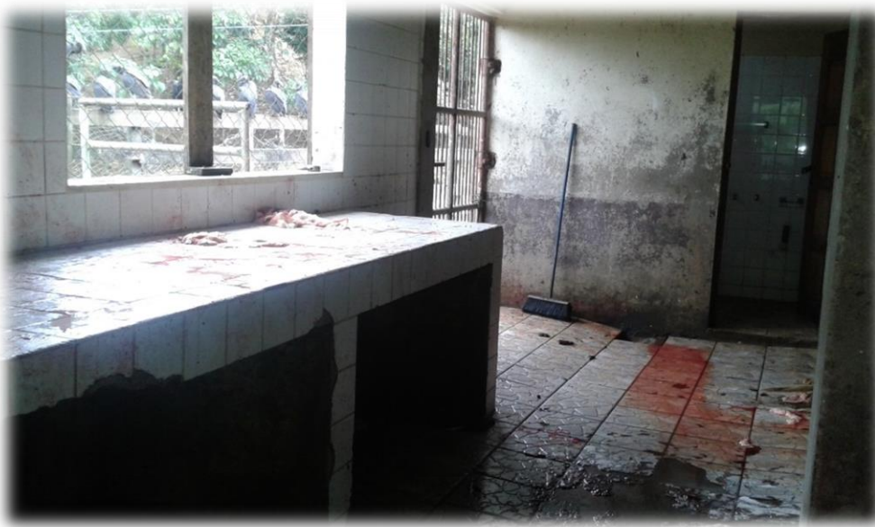
Ilustración 9: Piso antiderrapante en severas condiciones, portón arruinado.
