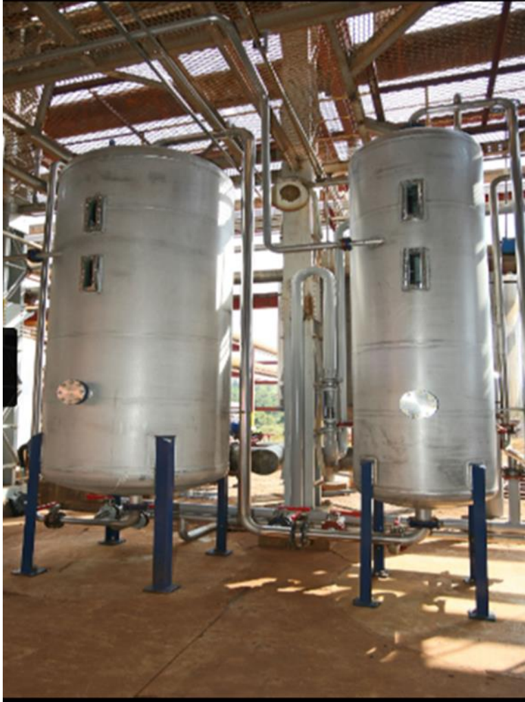
Figura 2.24. Equipo de purificación de bioetanol a escala piloto
